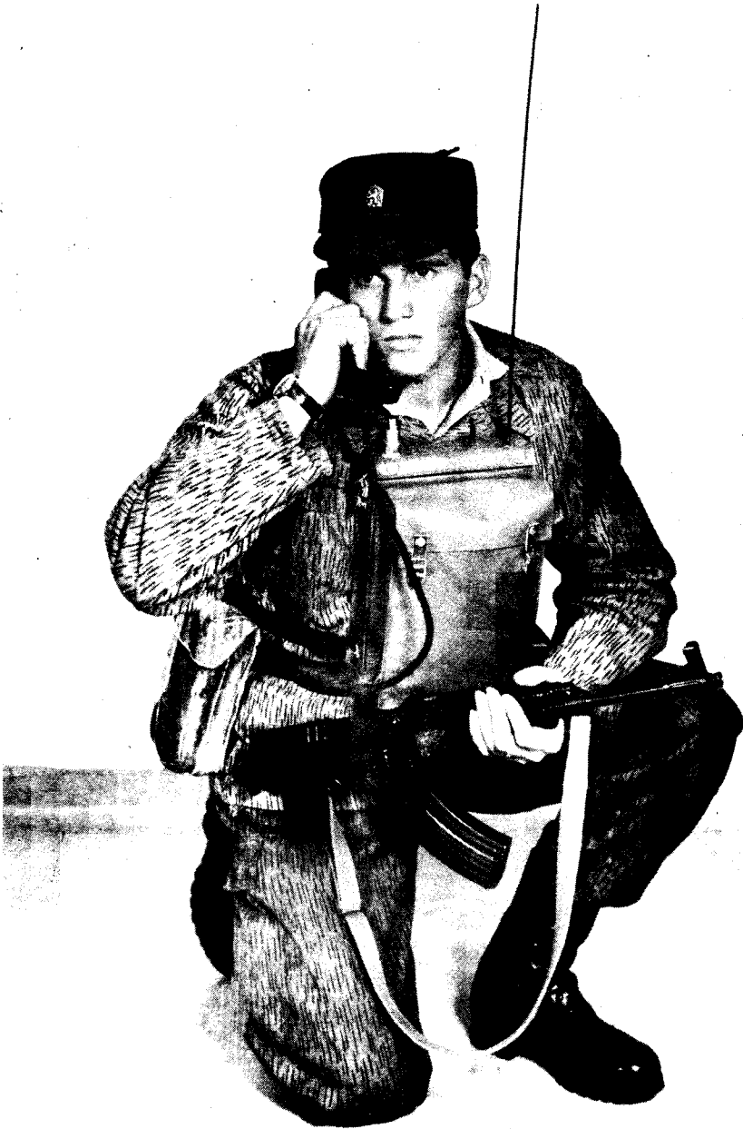
Obr. 5. Rádiová stanice v poloze "na prsou" - poloha vkleče
