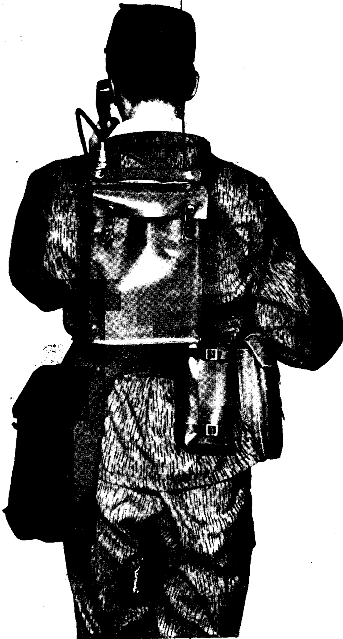
Obr. 8. Rádiová stanice v brašně v poloze "na zádech" - pohled zezadu - záložní zdroj svítle
